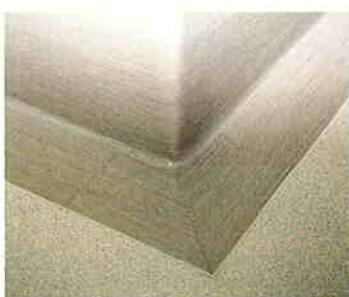
「ガード巾木・AC」の巻き下げ工法による施工例。
