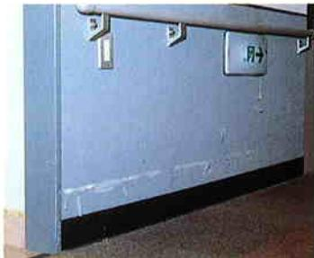
壁の下の部分は車椅子が当たり傷ついてしまう。車椅子がぶつかっても傷つきにくく、衝撃の少ない「ガード巾木・AC」を施工。床はソフトな歩行感の「ACフロア」を施工。
